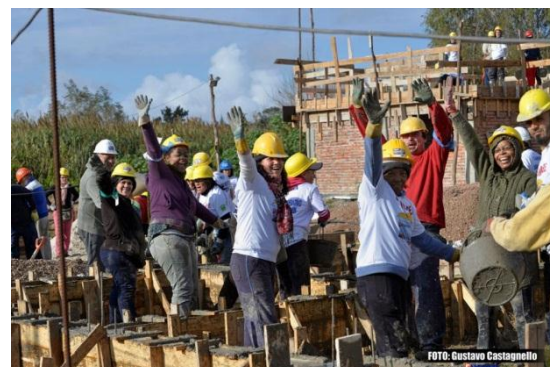
Chantier des auto constructeurs de la FUCVAM
